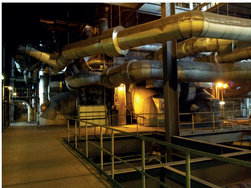
Obr. 4 – Pohled na sušky a kanály ofuku sušek uhelného kotle
