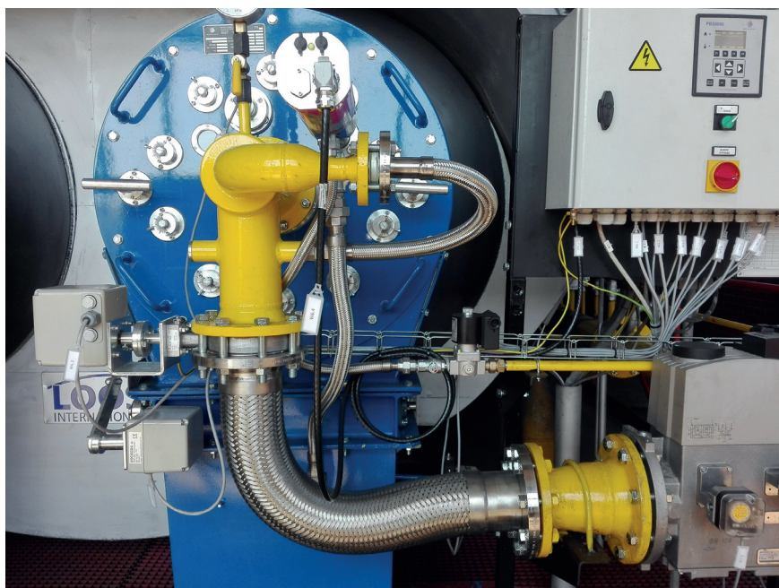
Obr. 1 – Čelní pohled na plynový kotel 15 MW
